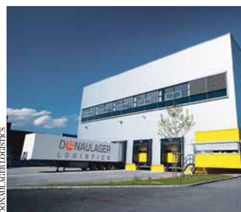
Gefahrgutlager für Lithium-Batterien
